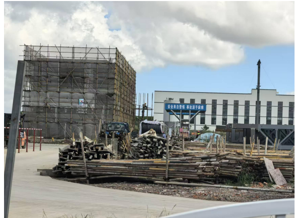
站址西侧艾威逊项目（在建）
